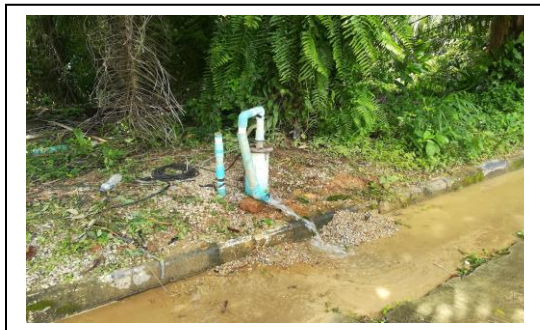
อธิบายได้ภาพ....ทำการเป่าบ่อทำความสะอาดจนน้ำใสสะอาดและนำชุดปั้มลงบ่อบาดาลดั้งเดิม จำนวน ๒ บ่อ.....
