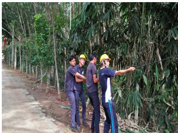
ปฏิบัติงานลากสายเมนไฟฟ้า เพื่อติดตั้งมิเตอร์ ๓ เฟส ศูนย์ฝึกอบรบวิชาชีพอำเภอสะเดา
