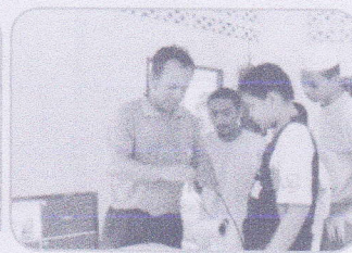
ช่างติดตั้งกล่องวงจรปิด สถาบันศึกษาปอเนาะอัลมะฮะดูลอิสลามมีย์
