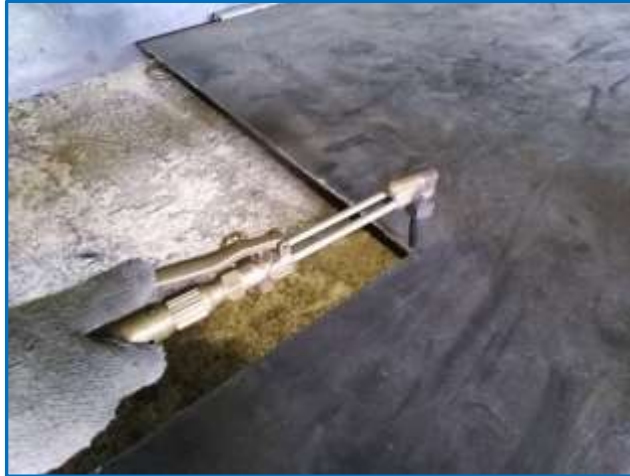
รูปที่ 5.15 แสดงการตัดแก๊สบังคับด้วยมือ
