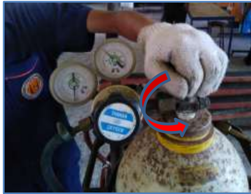
รูปที่ 4.15 แสดงการไล่ฝุ่นที่อยู่บริเวณทางออกของแก๊ส“แคร็กกริ่ง” (Cracking) ที่มา : นิโรจน์ เฟ็งศรี, 2562.
