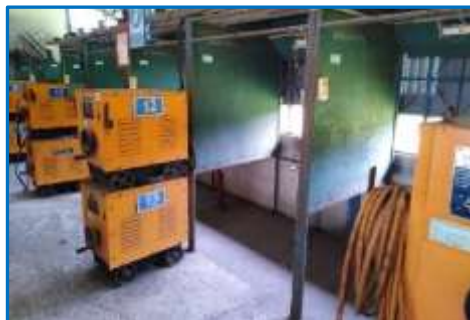
รูปที่ 1.4 แสดงงานเชื่อมไฟฟ้าควรมีฉากกัน เพื่อป้องกันแสงจากงานเชื่อมไฟฟ้ารบกวนผู้อื่น
