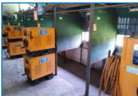
รูปที่ 1.4 แสดงงานเชื่อมไฟฟ้าควรมีฉากกัน เพื่อป้องกันแสงจากงานเชื่อมไฟฟ้ารบกวนผู้อื่น และควรมีอุปกรณ์ดูดควันเชื่อมที่เกิดจากการเชื่อม
